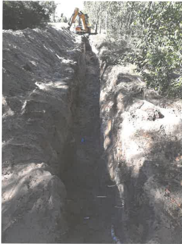
Budowa sieci wodociągowej w obrębach: Studzienki, Sipiory i Józefkowo
