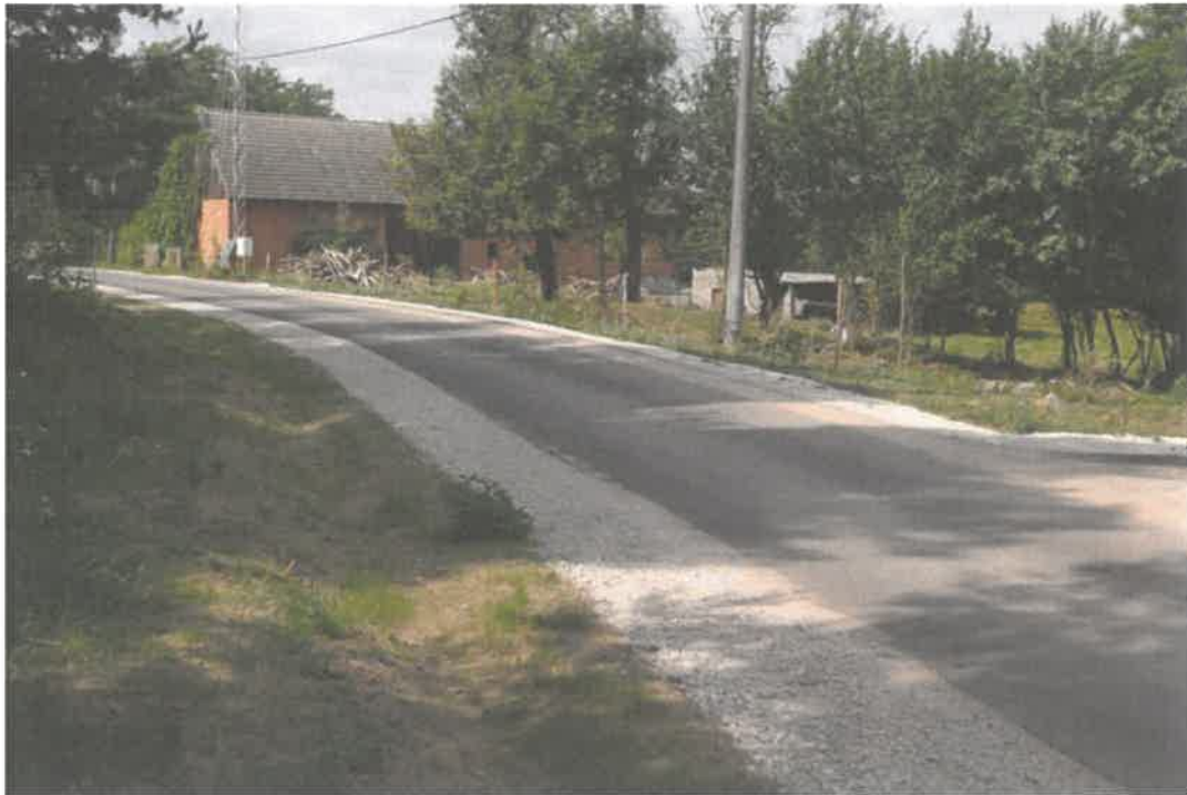
Droga w Mieczkowie, etap I zakończony
