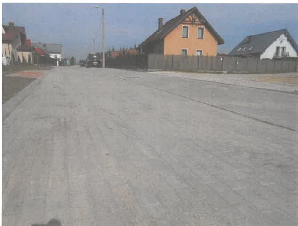
Ulica Kwiatowa w Kcyni po remoncie
